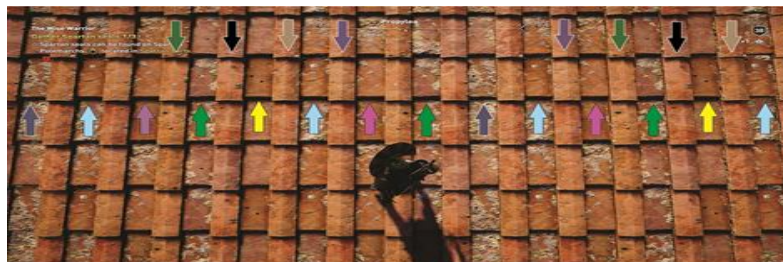
شکل ۳: وجود قطعات سفالی یکسان در یک ردیف از سقف
